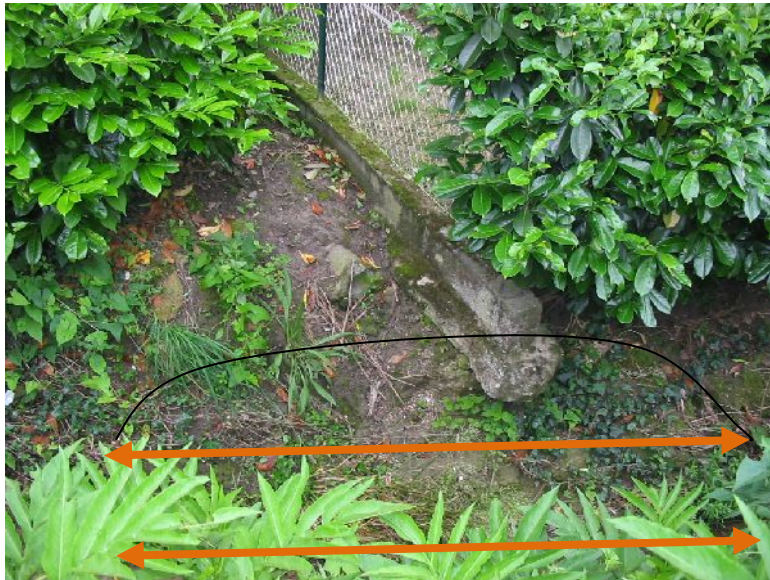
PETIT ENROCHEMENT DE STABILISATION EN PIED DE BERGE (SUR CHAQUE RIVE) ET RETALUTAGE
